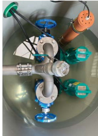
Werkseitig fertig montiert: So kommt das Doppelpumpwerk zur Baustelle.
