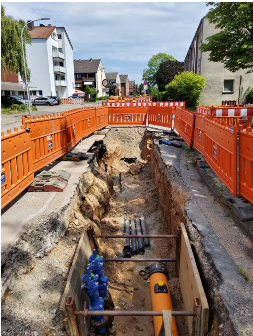
Abb. 1: Tiefbauarbeiten für Wasser-/Gas-/MSP-/NSP- und TK-Netz im Zuge einer Straßensanierung in der Mozartstraße in Neukirchen-Vluyn. Bild: ENNI Energie & Umwelt Niederrhein
