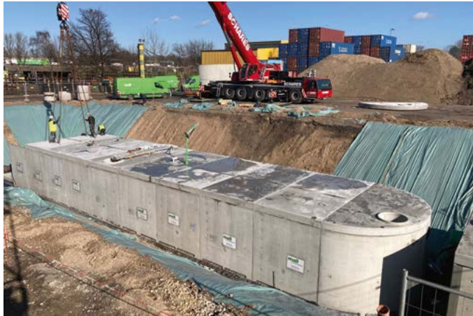
Fast fertig: Für den Regenablauf von 16.000 m 2 versiegelter Fläche bietet das Rückhaltebecken 440 m 3 Stauvolumen.
