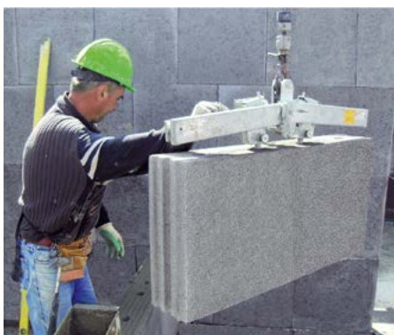
Einfache Handhabung: Dank moderner Versetztechnik und seiner Größe ermöglicht das KLBQuadro-Planelement einen raschen und effizienten Wandaufbau – bei geringem Personalbedarf.
