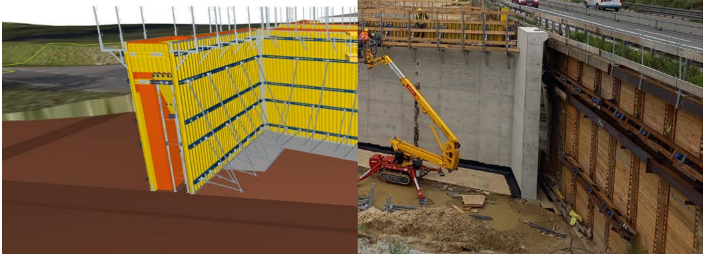
Abb. 1: Der digitale Zwilling schlägt die Brücke zwischen Planung und Ausführung. Bild: ARGE A10A24 Havellandautobahn
