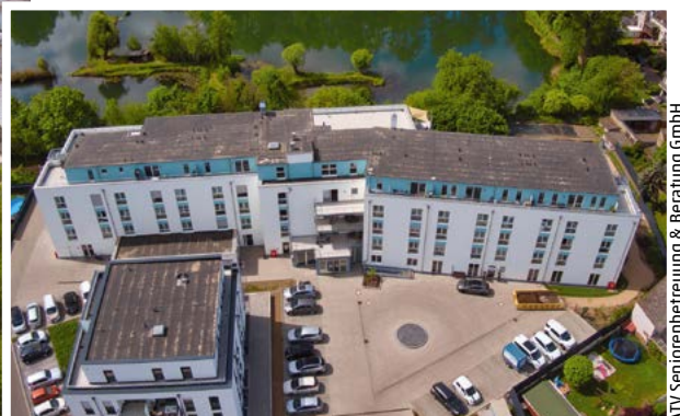
Vielfältiges Wohnangebot: Die Seniorenresidenz bietet im Erdgeschoss eine Tagespflege mit zwanzig Plätzen, 89 Pflegeplätze im ersten bis dritten Geschoss sowie elf Pflegeappartements im Dachgeschoss. Zwölf Seniorenwohnungen für betreutes Wohnen befinden sich im separaten Haus.
